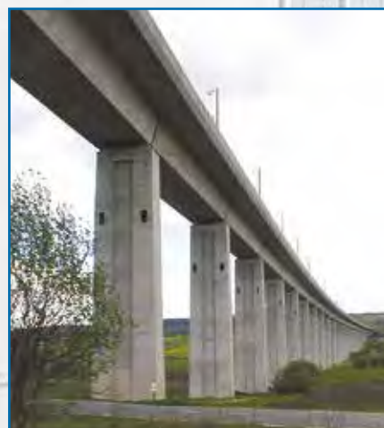
DB Trasse (Brückenbau)
